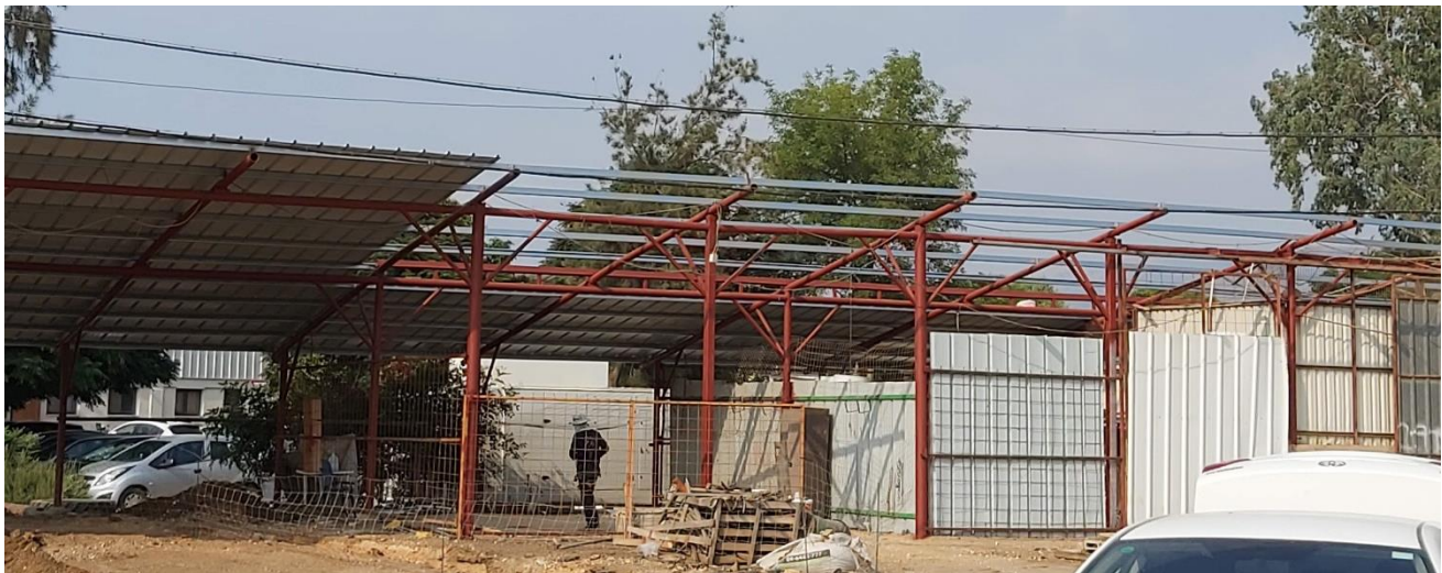
Figure 8 החלפת גגות אסבסט בסככת הטרקטורים כחלק מפרויקט סולארי 3
