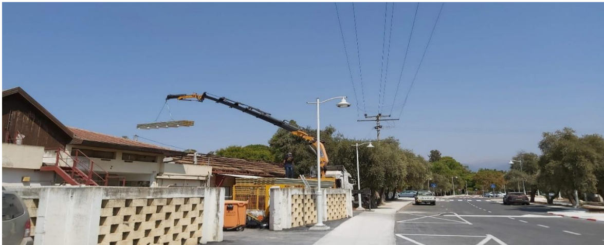
Figure 2 שיפוץ גג הכלבו – החלפת גג האסכסט הישן בגג חדש
